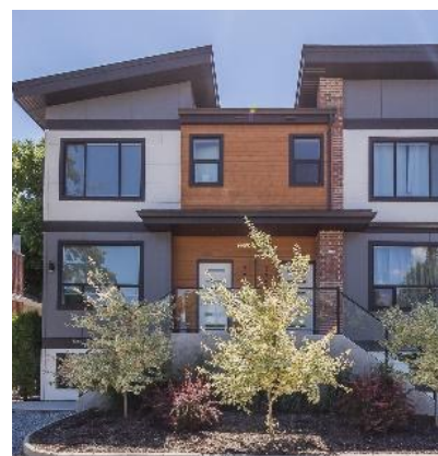
Exemple de sous-sol semi-enterré.
