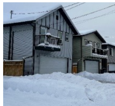
Ces maisons intercalaires ont une marge de recul d'environ 7 mètres qui permet le stationnement entre le bâtiment et la ruelle, et offre de larges rayons de braquage pour les véhicules qui entrent dans le garage et en sortent.
